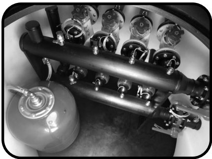
Übergeordneter Haupt-Verteilerschacht
